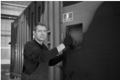
Montagearbejde på container
